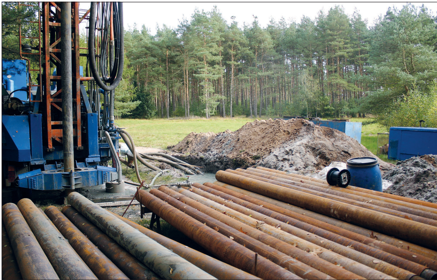
Nach 130 Metern war erst einmal Schluss: Große Luftblasen verhinderten zunächst, dass die Bohrung das Ziel in 200 Metern Tiefe erreichen konnte. Die Messstation in Rethem soll bald Informationen über weit entfernte Erdaktivitäten geben.
